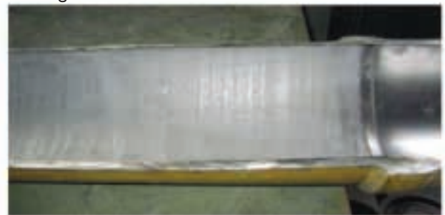
Sección transversal de tubo recubierto sin signos de desgaste
